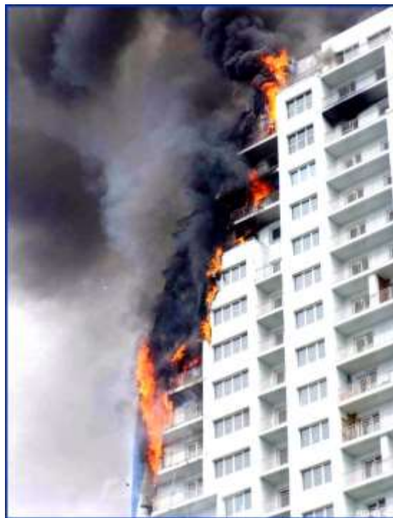
Рис. 2.22. Пожежа будинку з SIP панелей
