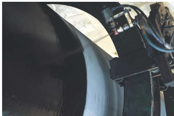
Рис.24 – Нанесення антикорозійного покриття „DENSOLID FK2”
