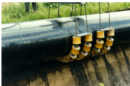
Рис.17 – Нанесення стрічки на газопровід
