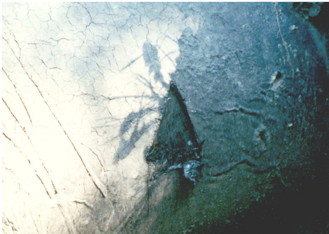
Рис. 69 – Перевірка ізоляції методом трикутника
