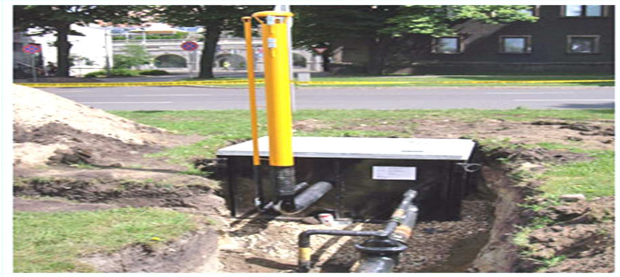
Рисунок 2.109 – Монтаж підземного ГРП
