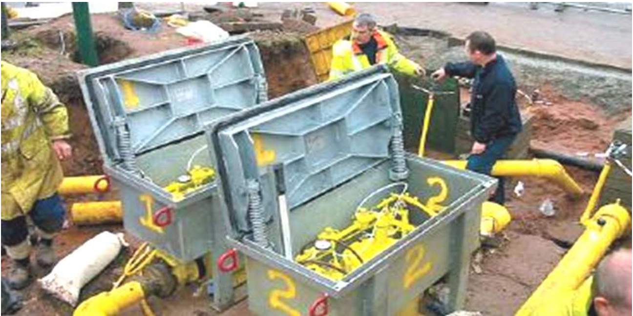
Рисунок 2.106 – Підземний ГРП
