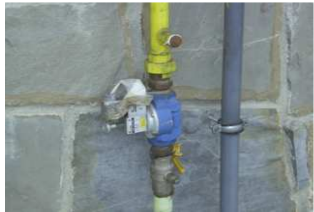
Рисунок 2.113 – ГРПШ з будинковим регулятором і лічильником газу та ввідний газопровід з відсічним клапаном та відліковим електронним обладнанням
