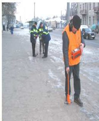
Рисунок 1.44 – Пошук траси і глибини газопроводу
