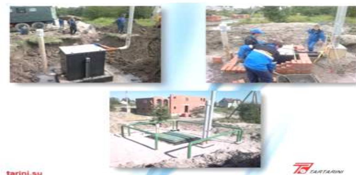
Рисунок 2.108 – Технологія монтажу підземного ГРП
