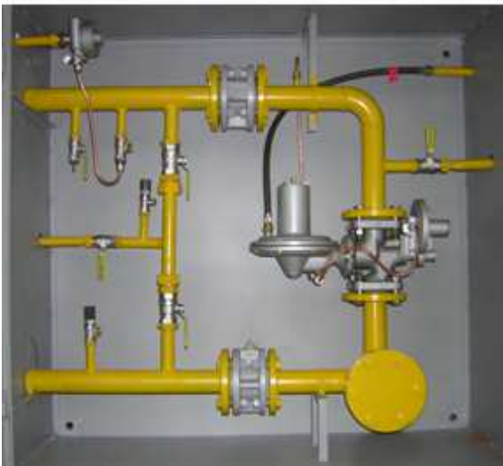
Рисунок Б.6 – ГРП з регулятором РДНК
