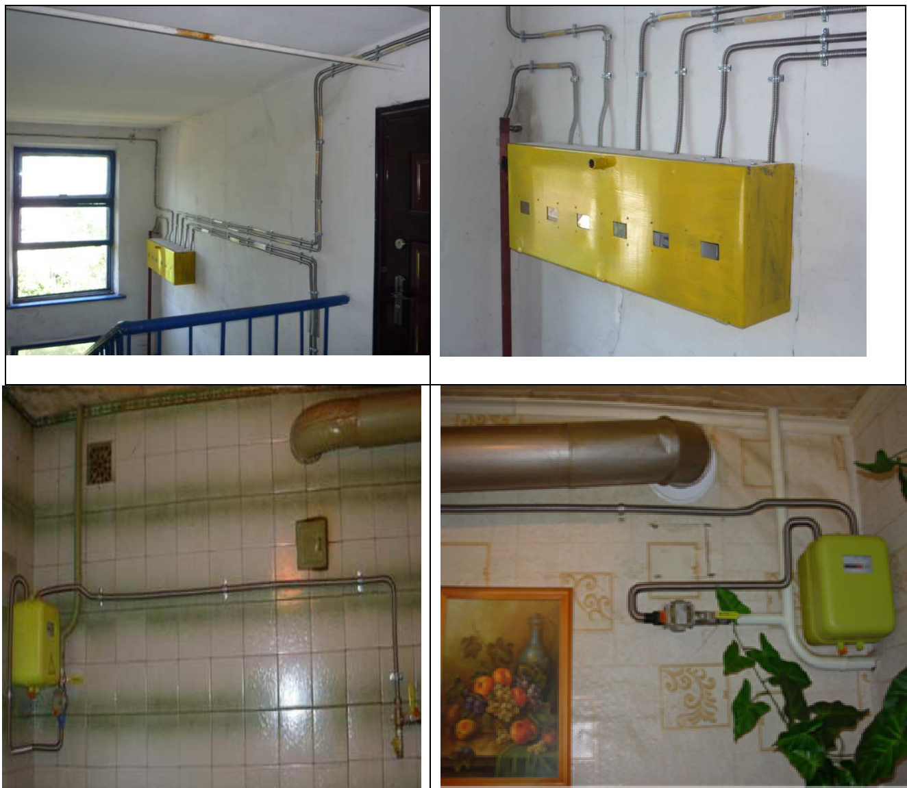
Рисунок 4.45 – Монтаж ВБСГ та газових лічильників гнучкими шлангами
