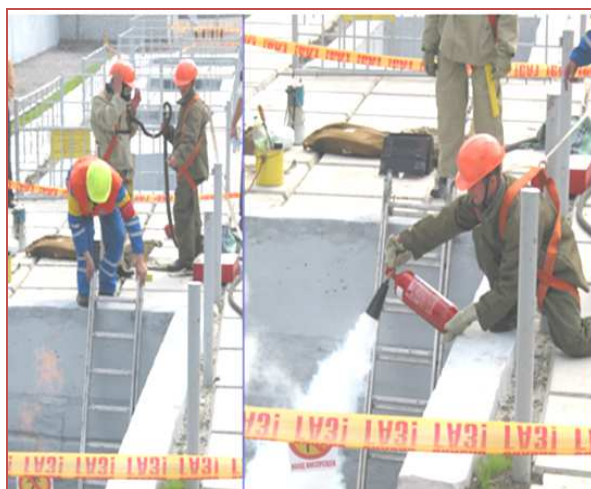
Рисунок 1.26 – Локалізація аварій з горінням газу в котловані
