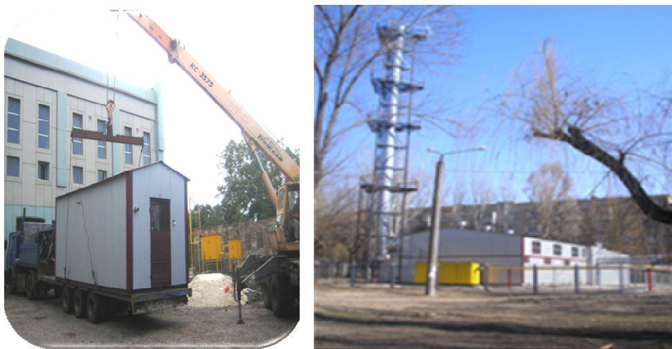
Рисунок 3.30 – Будівництво блочно-модульної котельної
