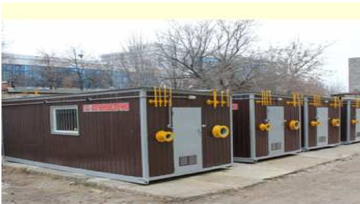
Рисунок Б 4 – ГРП блочного типу ГРПБ
