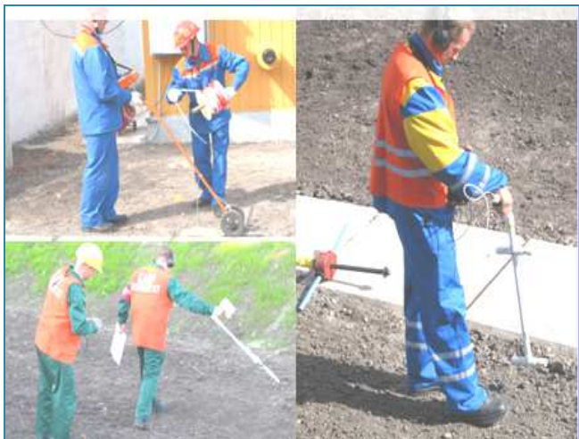
Рисунок 1.25 – Пошук витоків газу бригадами АДС
