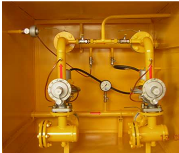
Рисунок Б.7 – ГРП з фільтрами-сепараторами
