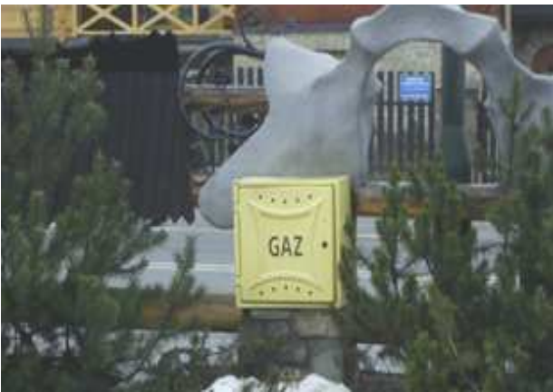
Рисунок 2.113 – ГРПШ з будинковим регулятором і лічильником газу та ввідний газопровід з відсічним клапаном та відліковим електронним обладнанням
