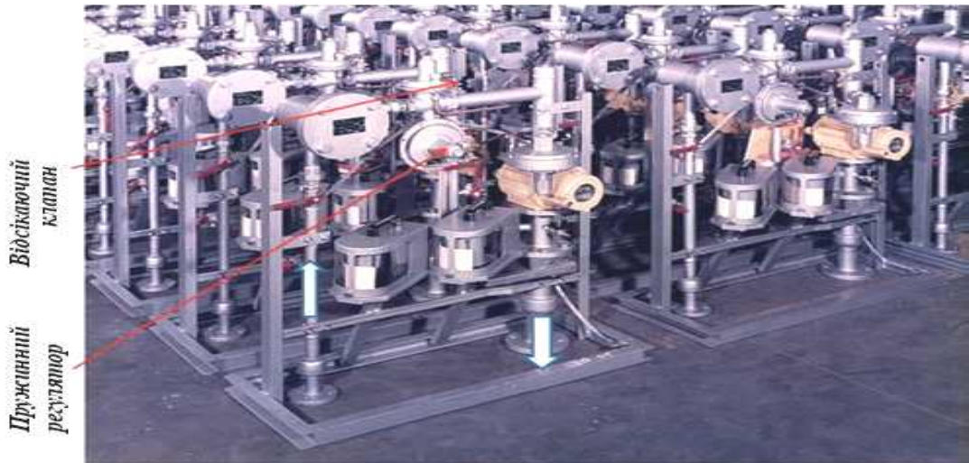
Рисунок 2.83 – Приклад готових ліній редукування, побудованих за схемою 1
