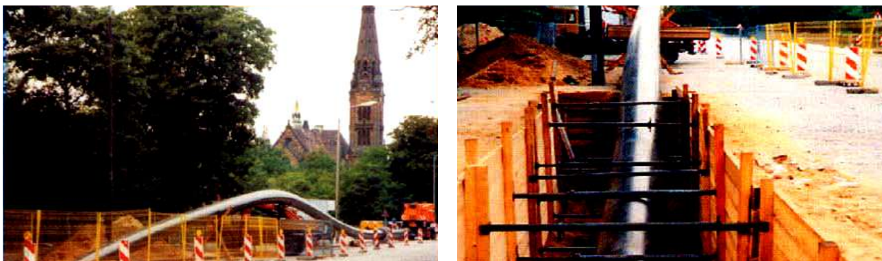
Рис. 2.35 – Монтажні й укладальні роботи
