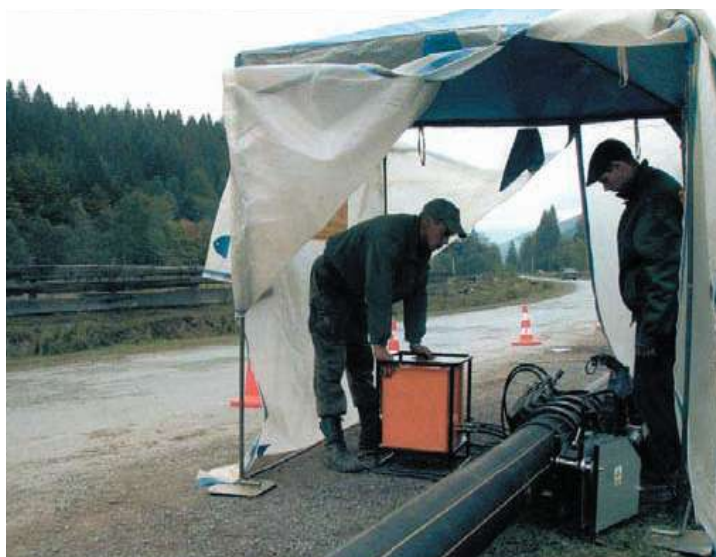
Рис. 2.56 – Захист місця зварювання ПЕ труб
