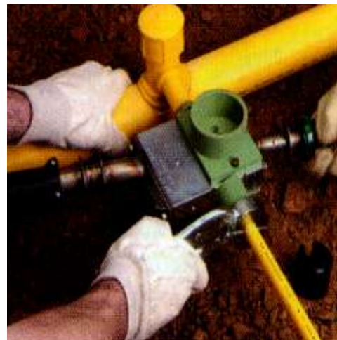
Рис. 2.58 – Зварювання ПЕ газопроводу врозтруб
