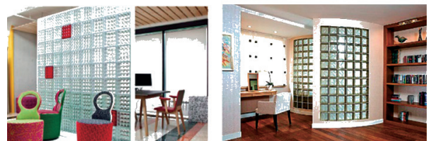
Рис. 7.2.3. Перегородка зі склоблоків:
