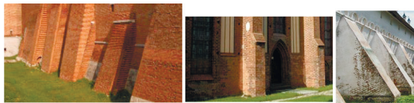
Рис. 4.5.7. Типи контрфорсів
