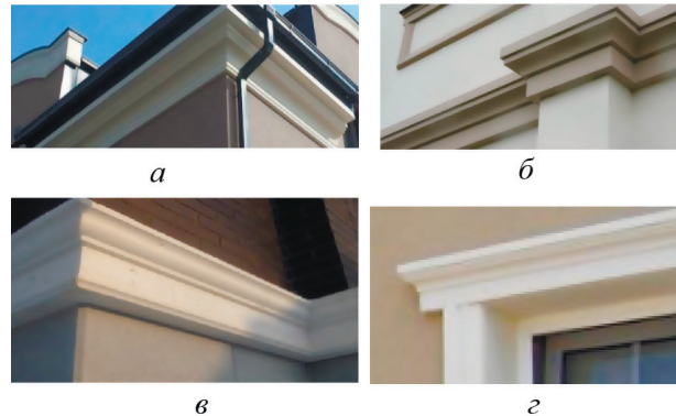
Рис. 4.5.3. Типи конструкцій карниза: а – вінцевий карниз; б – міжповерховий (поясний) карниз; в – цокольний карниз; г – сандрик
