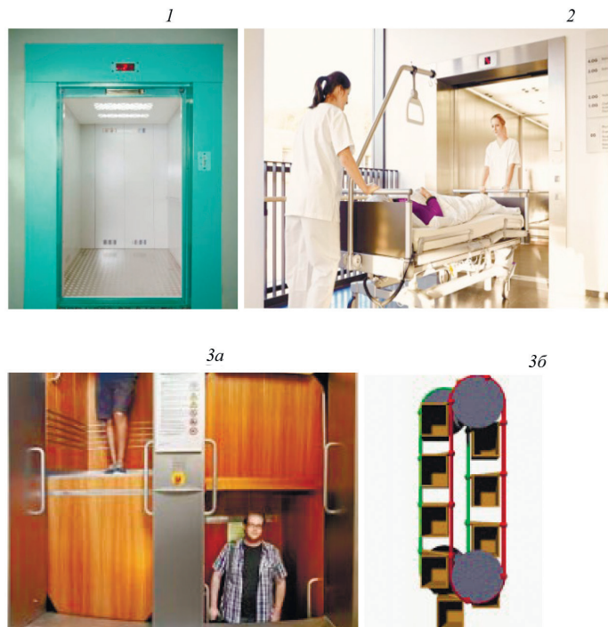
Рис. 10.4.8. Типи ліфтів та підійомник: 1 – вантажний ліфт; 2 – спеціальний ліфт; 3а – патерностер-підійомник; 3б – патерностер-конструкція
