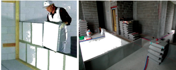
Рис. 7.2.1. Перегородки з гіпсових і легкобетонних плит:
