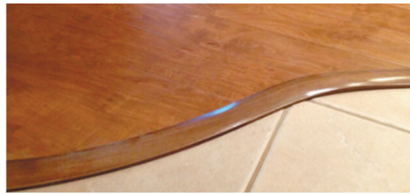
Рис. 6.1.7. З'єднання різних підлогових матеріалів
