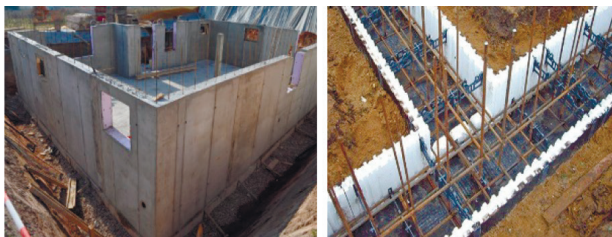
Рис. 4.4.1. Влаштування монолітних стін з різними типами опалубок:
