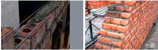
Рис. 4.2.5. Армування цегляної кладки
