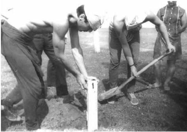
Рис.135. Закріплення основних точок кривої
