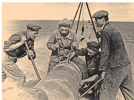
Прокладання першого магістрального газопону «Дашава–Київ». Фото. 1948 р.
