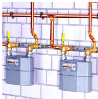
Рисунок 5.9 – Готові прес-з'єднання з мідних труб та фітингів та приклад монтажу
