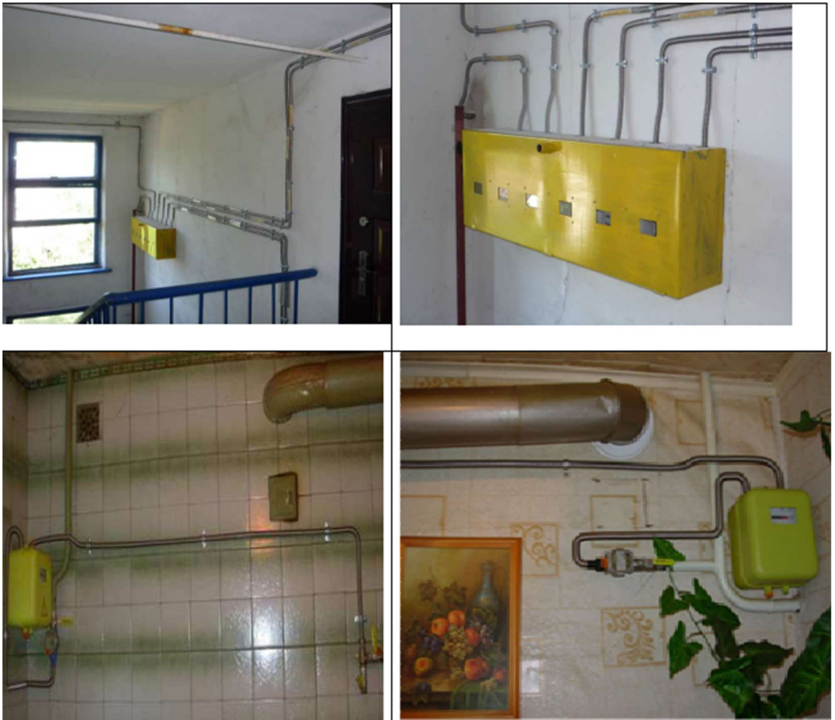
Рисунок 5.7–Монтаж ВБСТ та газових лічильників гнучкими шлангами
