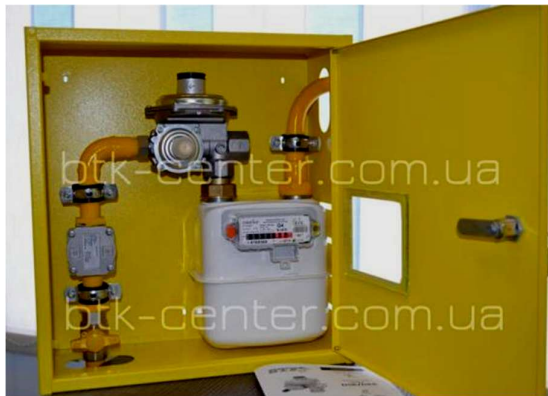
Рисунок 2.1 -Пункт газовий шафовий з комбінованим регулятором тиску
