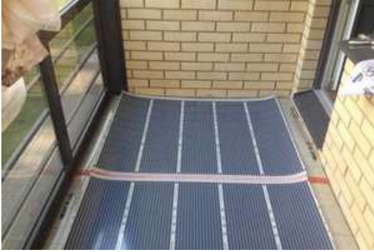
Рисунок 5.2 – Новітнє обладнання для опалення типу ПЛЕН
